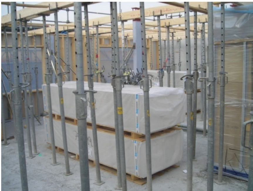
Bild 5.12 Mellanrummet mellan stämpan är ibland litet.
