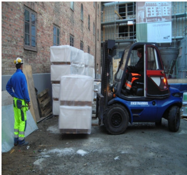
Bild 5.6 Avlastning av truck på byggarbetsplatsen.
