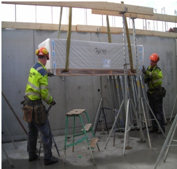
Bild 5.10 och 5.11 Mottagning av gips uppe i huskroppen, observerad av observatör ”på taket”.
