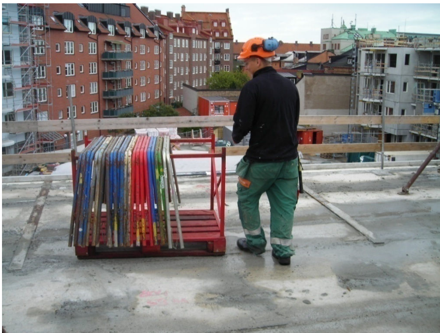
Bild 5.16 En pall med gipsbockar lyftes upp med kranen.
