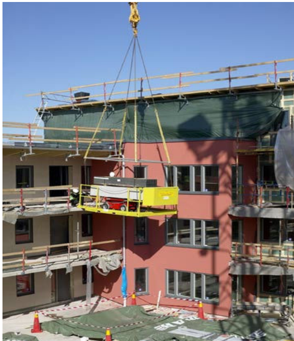
Bild 5.21 Plattform som landar på ett våningsplan med hjälp av en tornkran. Bild tagen från www.bygglogistik.se .
