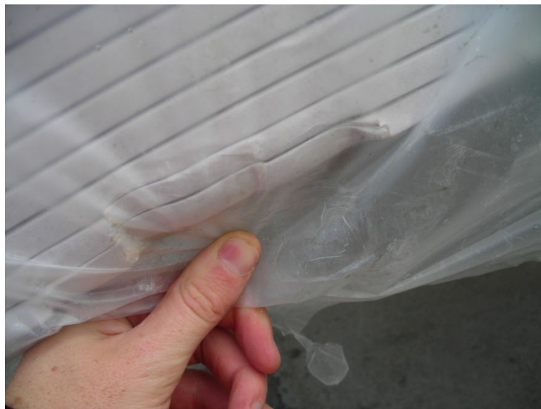
Bild 5.18 De tre understa gipsplattorna skadades av stropparna vid inlyften.
