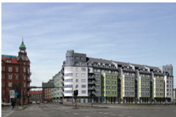
Bild 5.5 Färdigställd Svante blickad norr ifrån.
