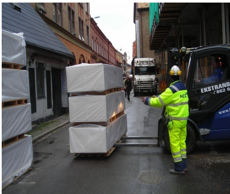
Bild 5.14 Trucken lossar gipset på trottoaren utanför bygget.
