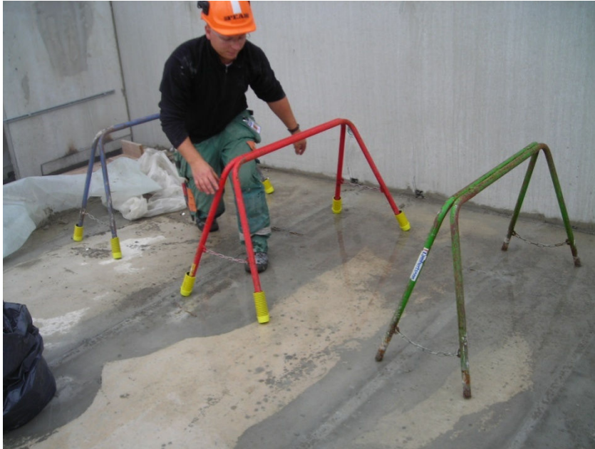
Bild 5.19 Tillrättställning av gipsbockar.
