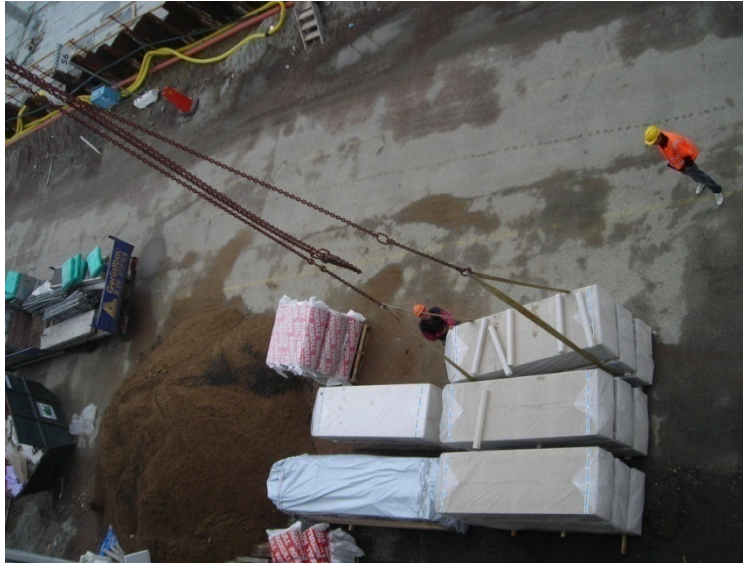
Bild 5.17 Början av ett gipsinlyft direkt efter stroppning
