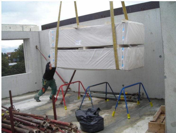
Bild 5.20 Mottagning av gips som ska placeras på gipsbockar, sekunden innan observatör hjälper till. Ofta låg annat material i vägen som fick röjas bort.
