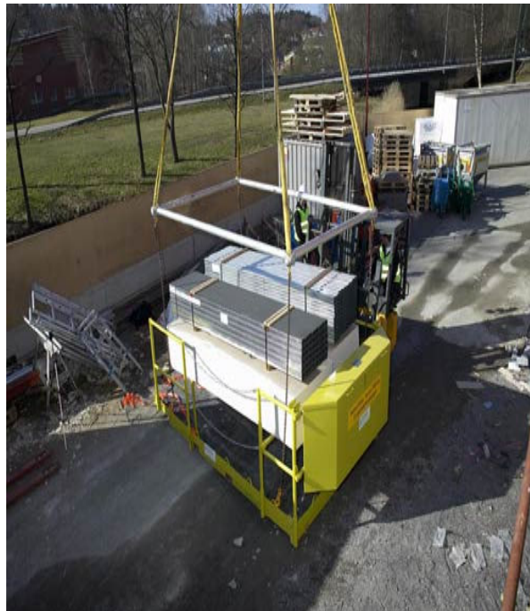
Bild 5.22 Truck som lastar på gips och stålreglar på en plattform. Bild tagen från www.bygglogistik.se .
