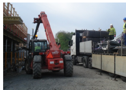
Figur 1: Lossning med lull
