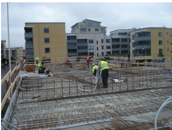
Figur 9: Samtidig armering, elinstallation och utsättning på plattbärlag i projekt C.
