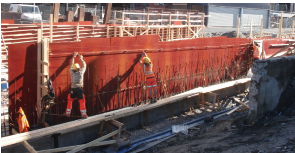
Figur 13: Balansering på armeringsjärn samtidigt som monteringsjärn najas på plats.
