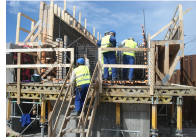
Figur 5: Handflytt och montering
