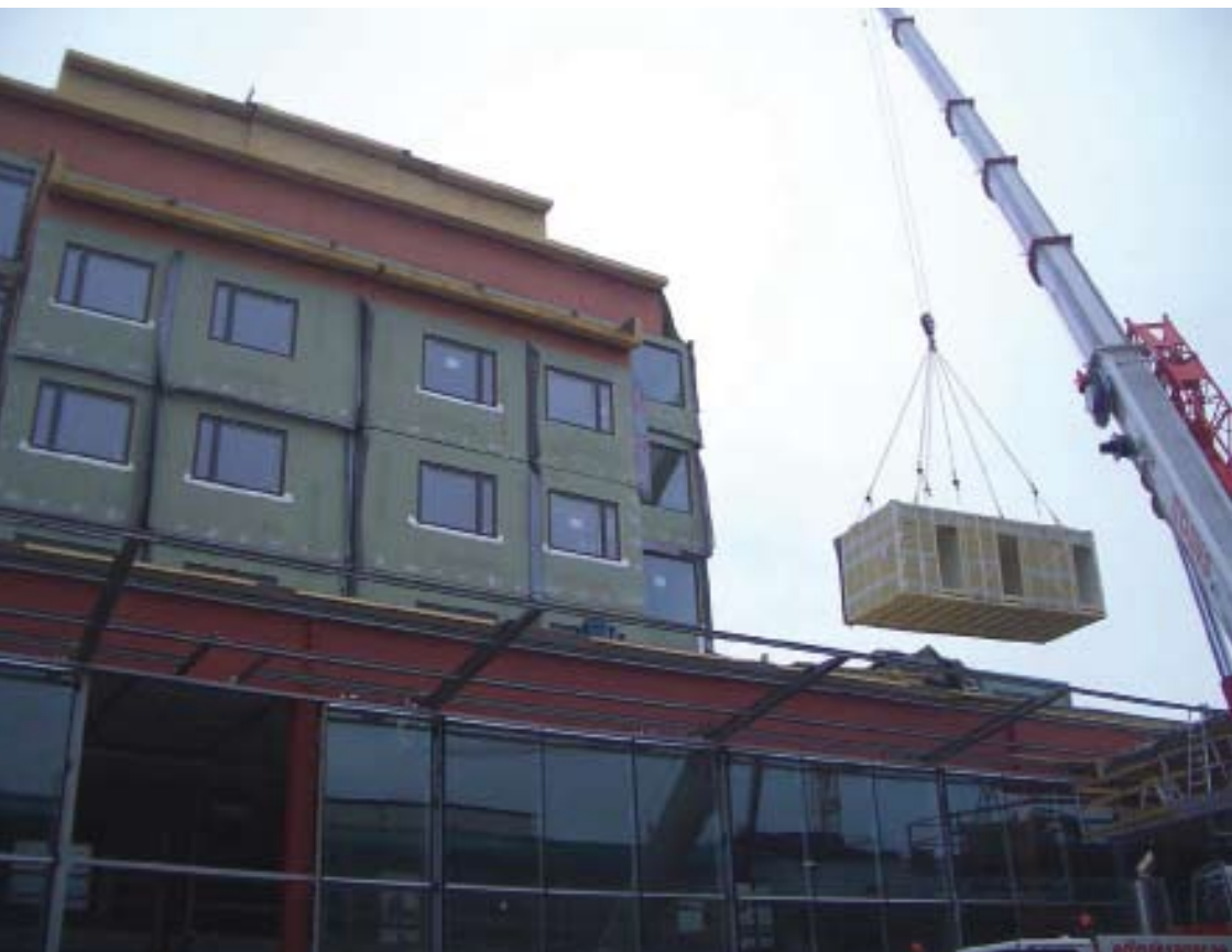
Montering av volymelement. Foto: Fredrik von Platen.
