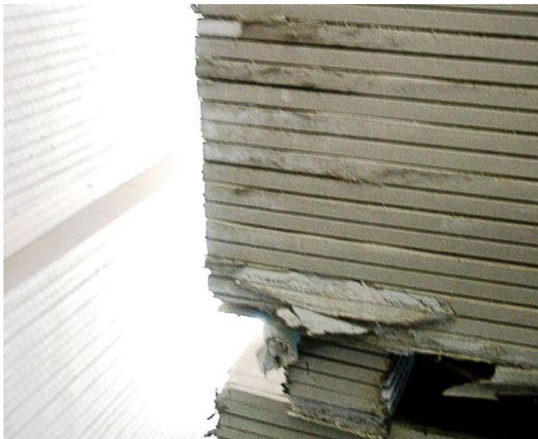
En vanlig syn på en dåligt organiserad byggarbetsplats. Foto: Per-Erik Josephson
