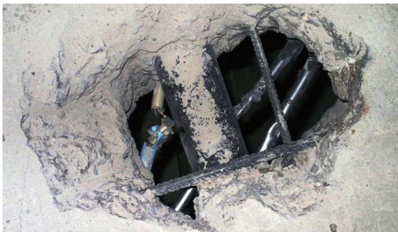
20 procent av håltagningar i bjälklag är fellokaliserade eller är inte utförda. Foto: Per-Erik Josephson
