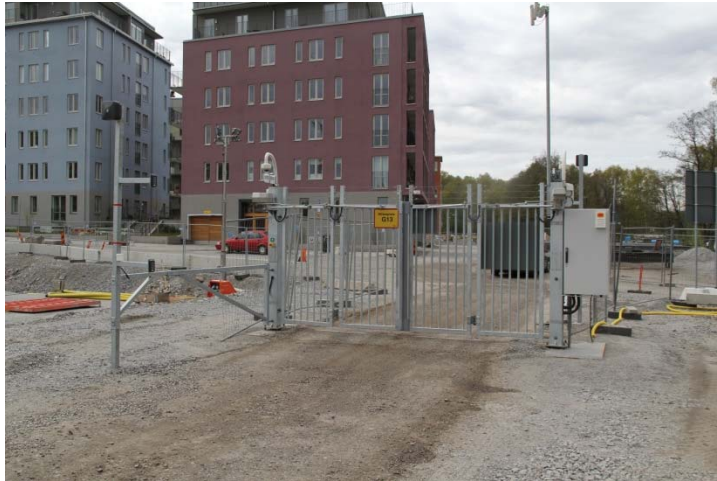
Figur 9: Bild visar vikgrind med radiolanmast och kameraövervakning
