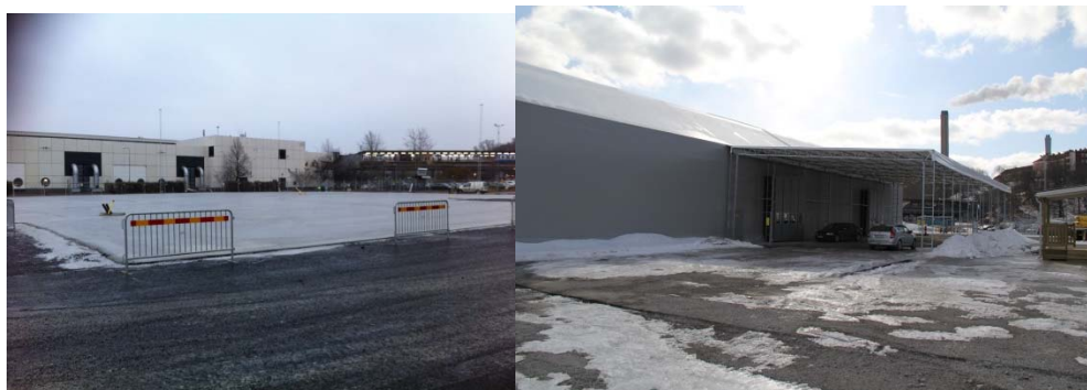
Figur 10: Byggnation av BLC vintern 2012/2013
