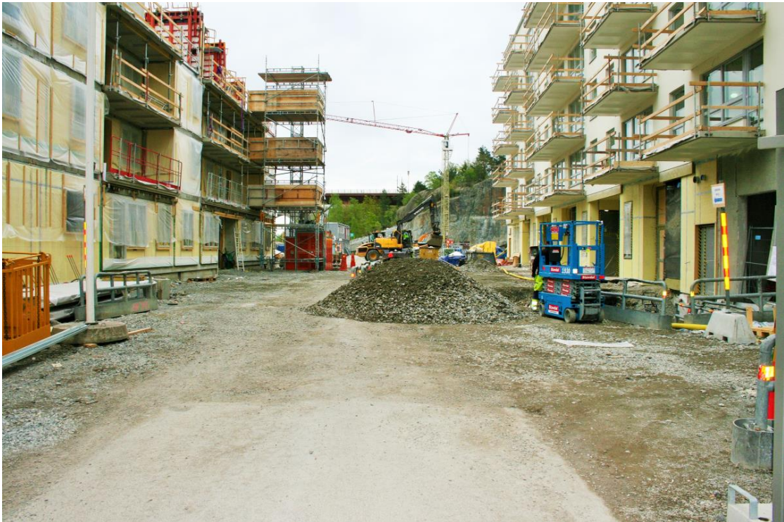
Då infrastruktur produceras parallellt med bostäder kan anläggningsarbeten medföra störningar.
