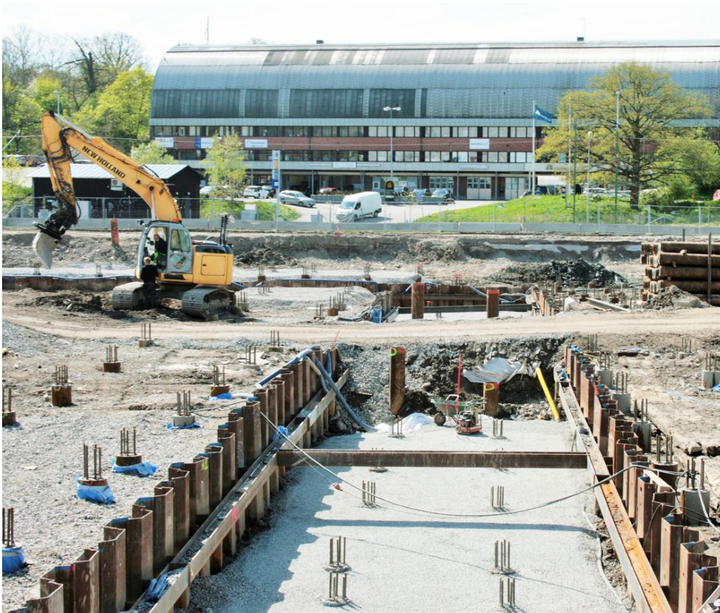
Vid infrastrukturarbeten uppstår arbeten som spontning, schaktning och pålning.
