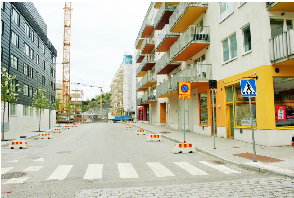
Infarten till arbetsplatsområdet vid Liljeholmskajen är placerad mellan bostadsrättsföreningarna Årgången och Ekfatet 1.
