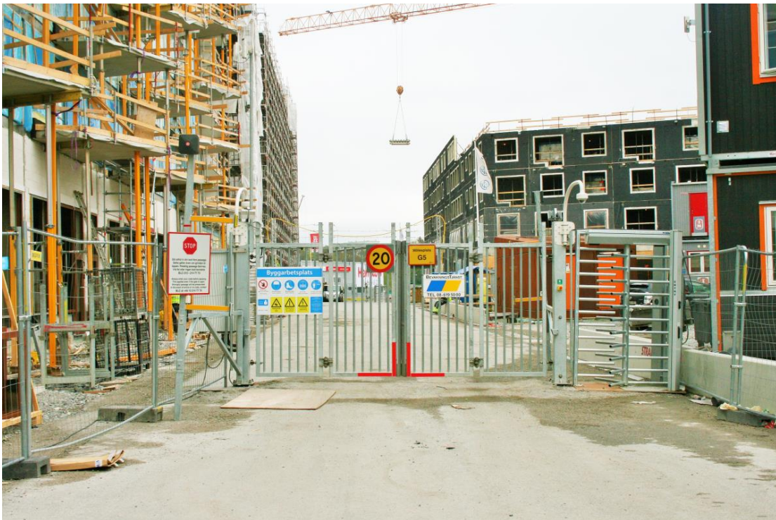
Ett tidigt färdigställande av infrastrukturen leder till en bättre arbetsmiljöplanering bland annat då planering av in- och utfartsvägar blir enklare.
