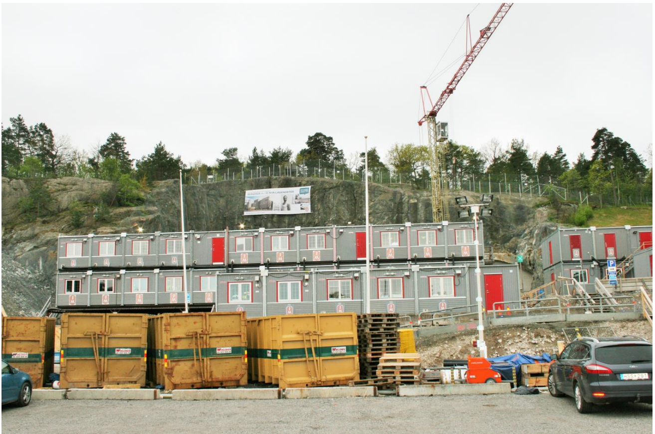
Byggavfall sorteras in i olika fraktioner, vilket bland annat kan innefatta brännbart och gips.
