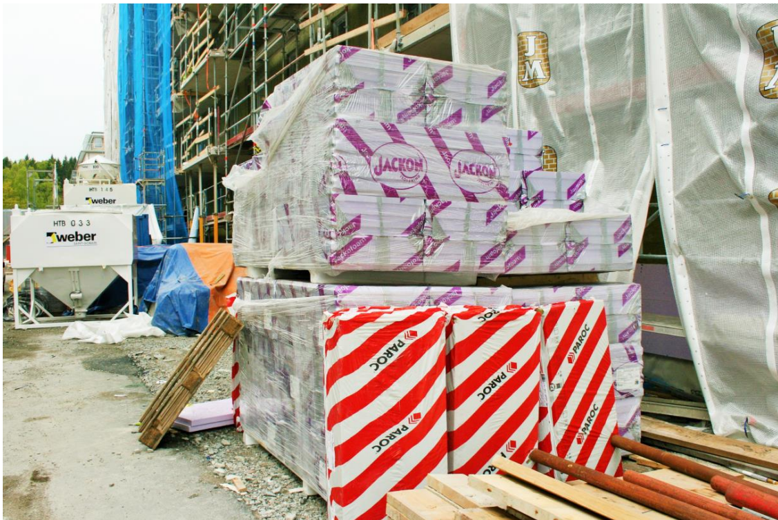
Vid isoleringsarbeten kan exempelvis skivor i polystyren användas.
