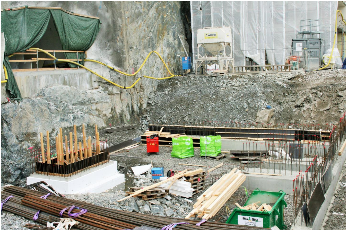
Vid Liljeholmskajen utför JM bland annat grundläggningsarbeten.
