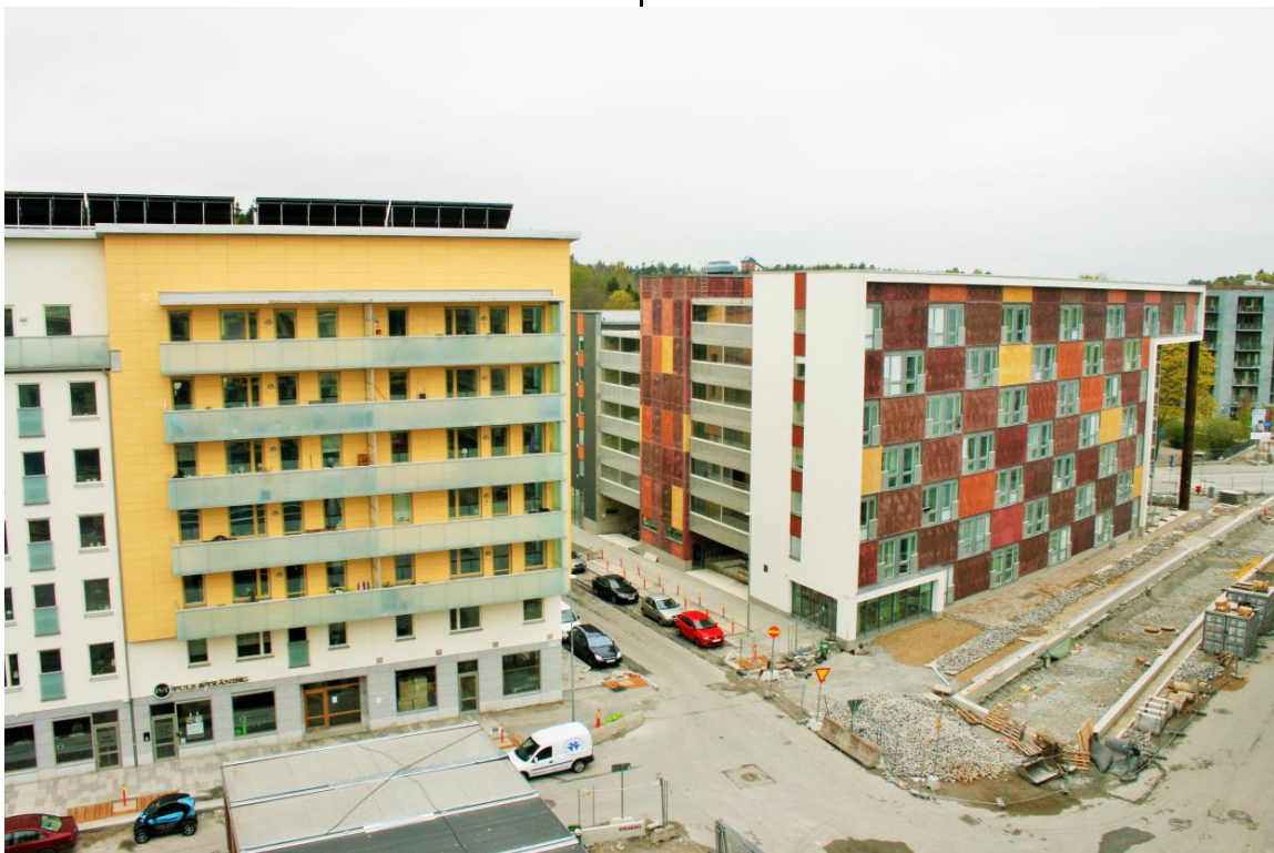
Infrastruktur exklusive finplanering bör färdigställas i ett tidigt skede för tre kvartersmarksområden. Finplaneringen bör utföras innan kunderna flyttar in bostäderna.
