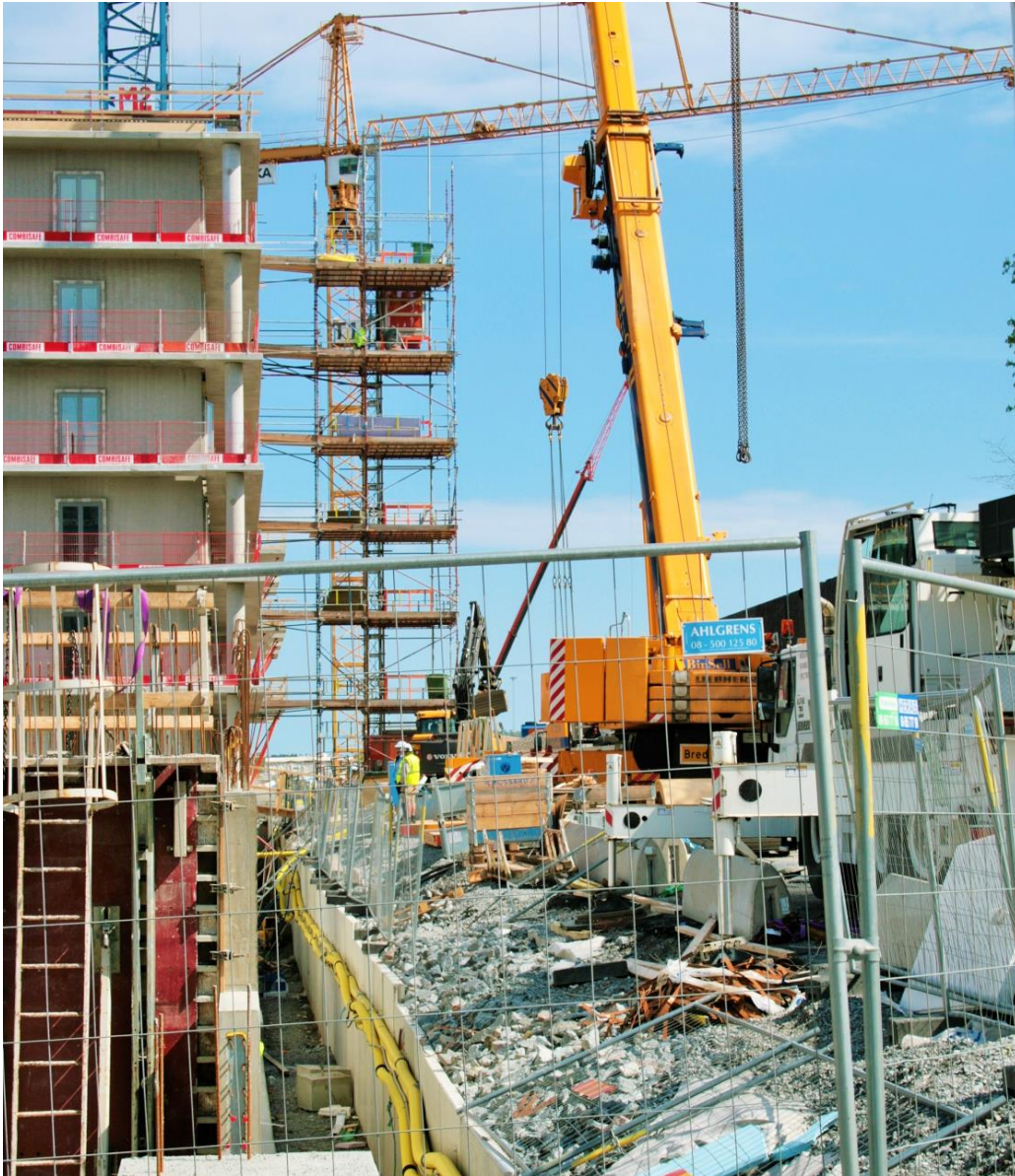
I Norra Djurgårdsstaden används stödelement gjutna i betong för att möjliggöra breda arbetsgator.
