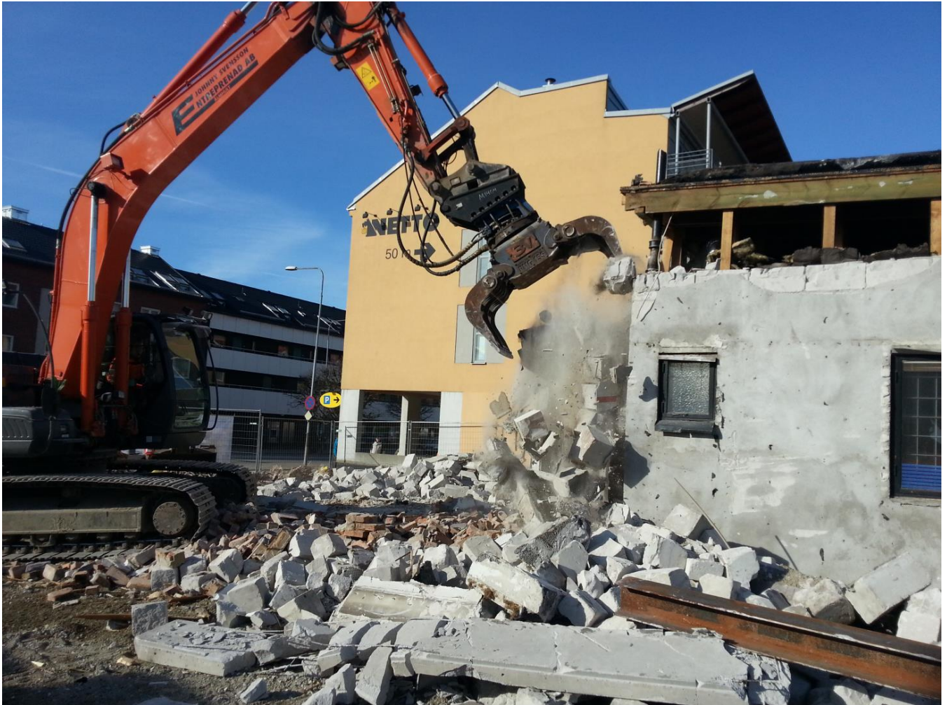
Vid markförvärv finns ofta befintlig bebyggelse på fastigheten. Denna bebyggelse kan exempelvis utgöras av gamla industri- och energianläggningar eller bensinstationer som behöver rivas innan byggnationen inleds. (Älmby, 2015)
