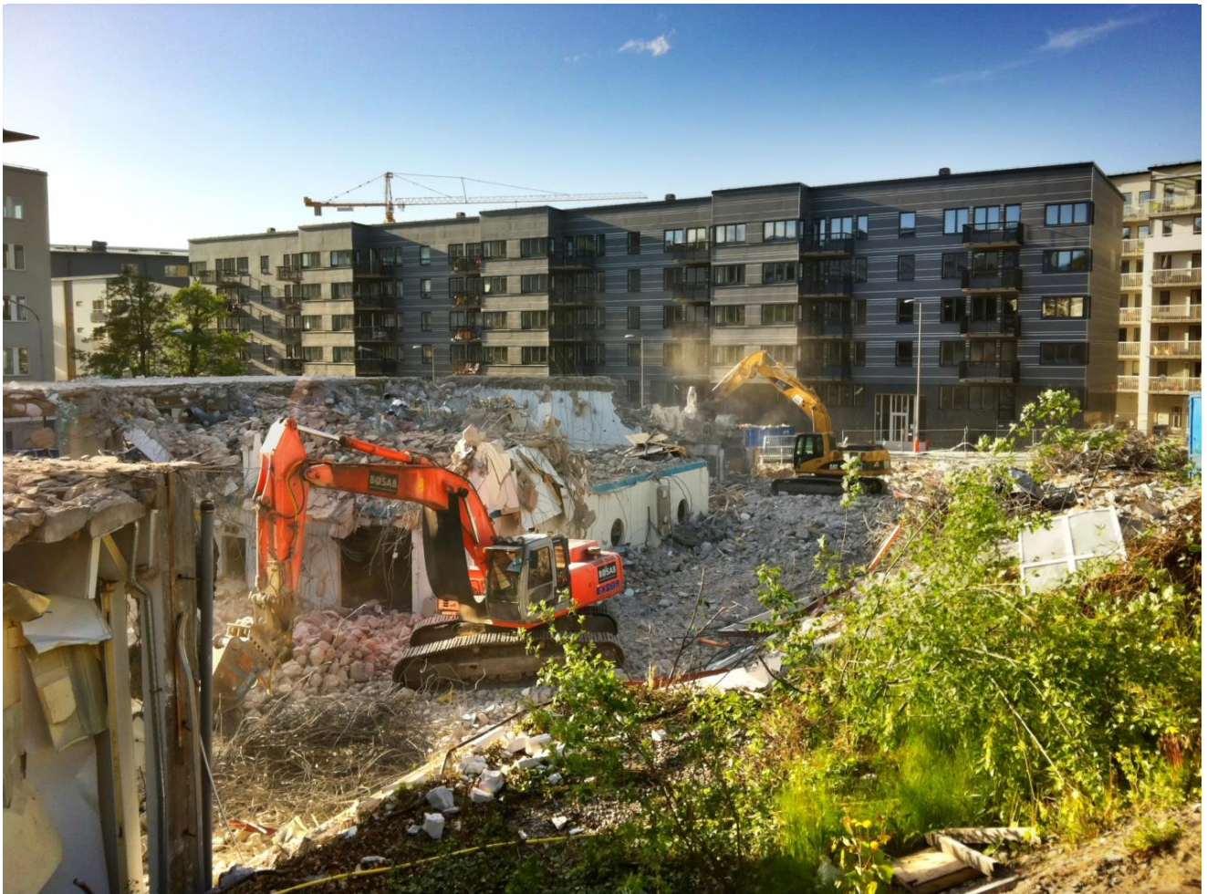
Innan marksanering startar utförs rivningsarbeten av befintlig bebyggelse (Garvander, 2011)
