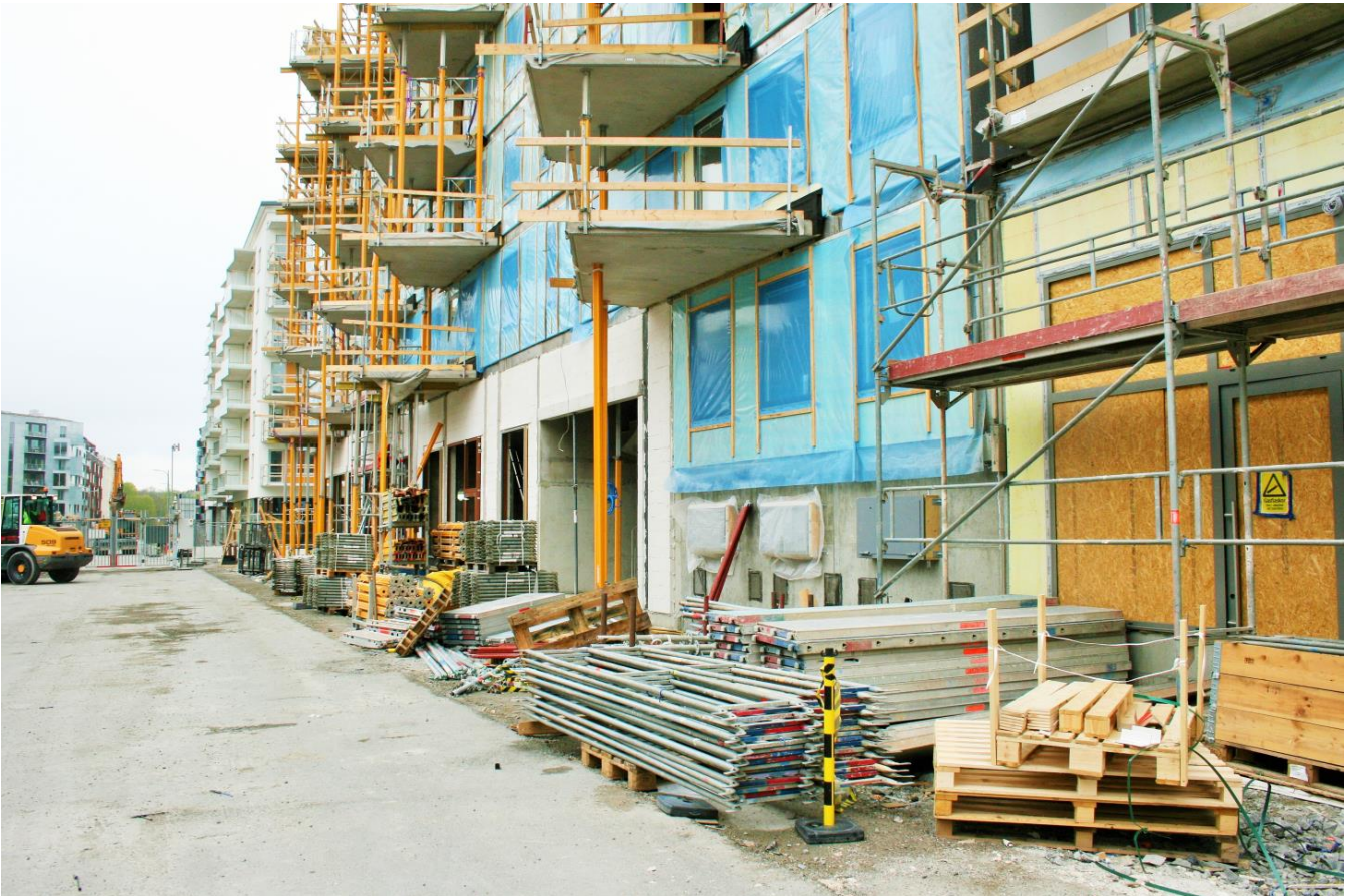
I Norra Djurgårdsstadens västra del används utrymmet mellan fasad och arbetsgator som upplag för byggnadsställningar och material.
