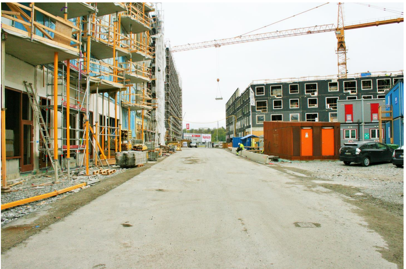
I Norra Djurgårdsstaden utförs finplaneringsarbetena i ett senare skede för att undvika skador och slitage från arbetstrafik.
